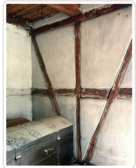
Fachwerk von innen, Gefache in Kalk
