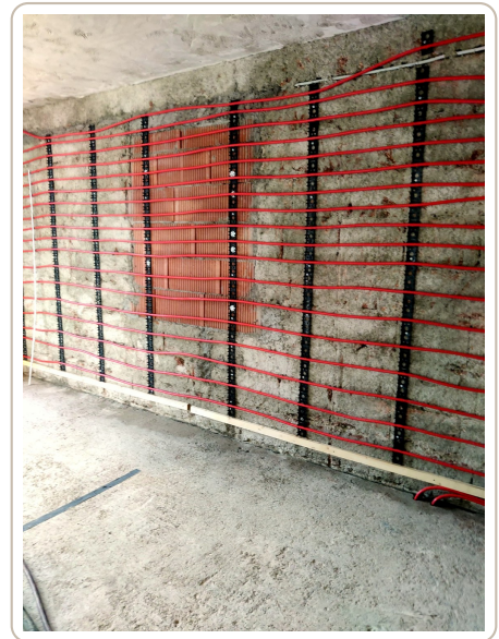
Wandheizung vor dem Verputzen
