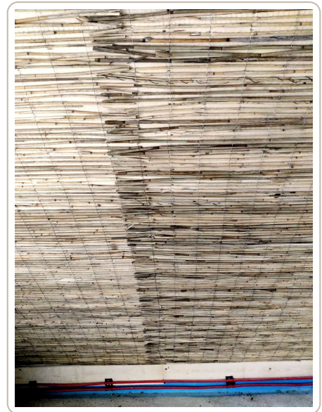
Schilfrohrmatte als Putzträger
