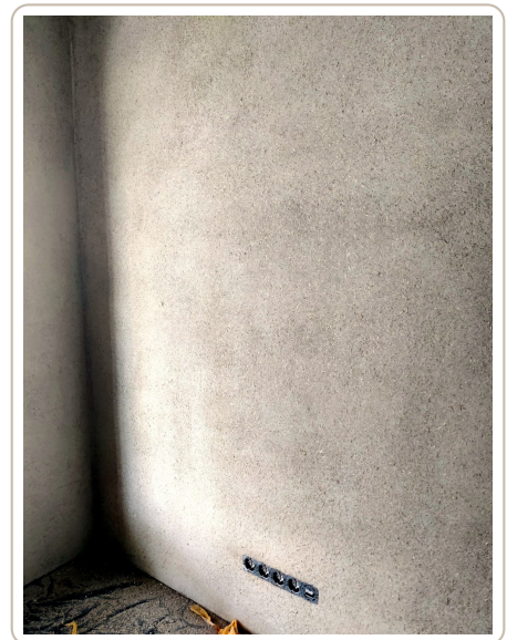
Fein abgezogener Lehm-Oberputz
